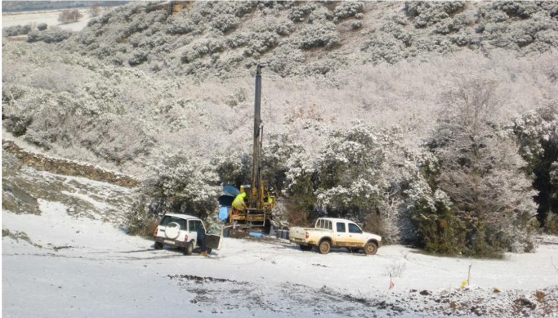
Figura 3. Realización de sondeo dentro de la zona de estudio.
